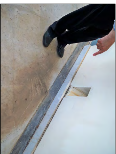
Φ. 2 Υδρορροή ενσωματωμένη στο πάχος του τοίχου
