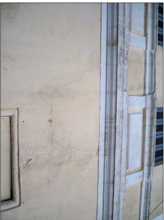
Φ. 1 Ρυγμές στην τοιχοποιία, φθορές σε επιχρισματα και διαζώματα
