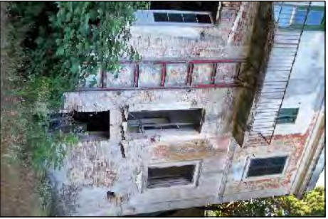
Φ. 10 Κατεστραμμένοι εξώστες όψης ( α) Φ. 10 Αποδιοργάνωση τοίχου όψης ( α)
