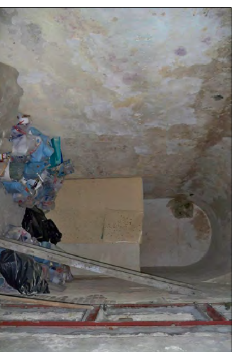
Φ10. ΧΩΡΟΣ 9, μεταλλικές ενισχύσεις τοιχοποιίας
