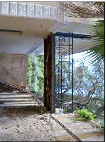
Φ. 3 Η μεταλλική γέφυρα πρόσβασης στον Α΄ όροφο
