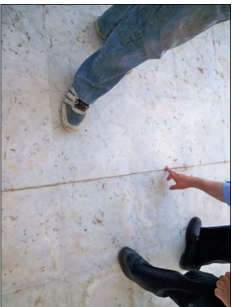
Φ. 1 Είσοδος υγρασίας στο διευρυνόμενο αμιούξ στις βεράνες
