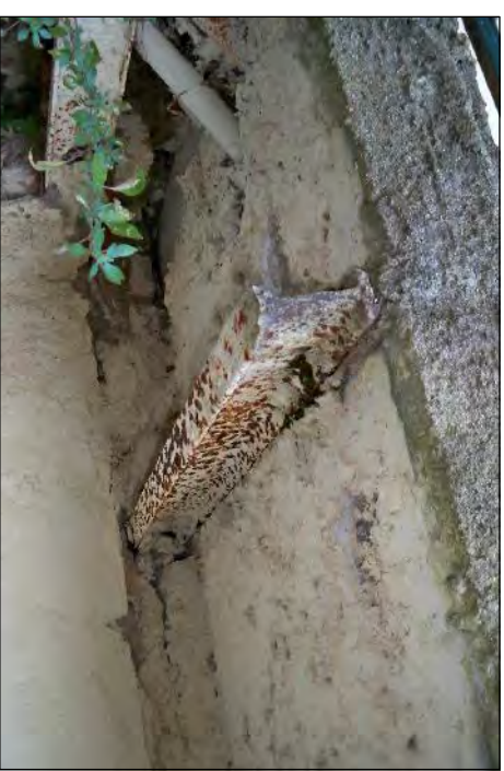
Φ. 7 Διεργασία μεταλλικού φορέα στον εξώστη της πλάγιας όψης ( θ)
