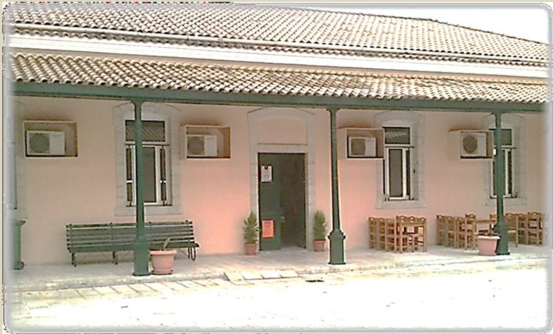
Το καινούριο Φοιτητικό Εστιατόριο, στο νέο Campus Β, Ψυχιατρείο
